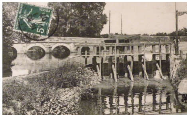
Vue du Bief de Colmet fin XIX/début XXe avant la construction de l'actuel clapet
