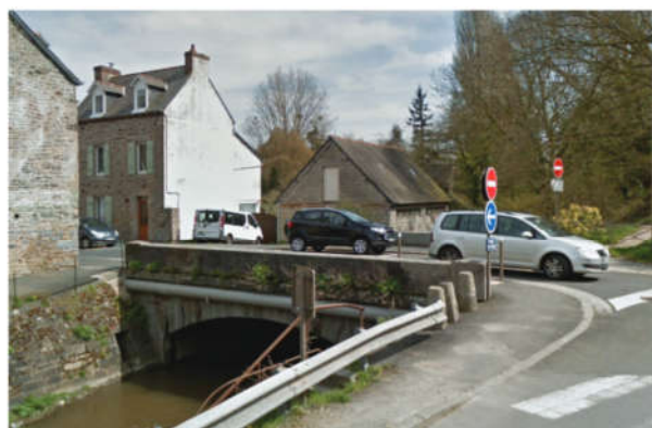
Le pont sur la vieille rivière vue depuis le chemine de la Geste
